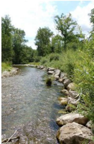
Enrochement de pied de berge sur l'Allondon (Suisse). © Léon Ducasse.
