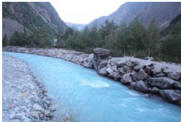
Enrochement de berge sur le Vénéon. © Nathan Daumergue.
